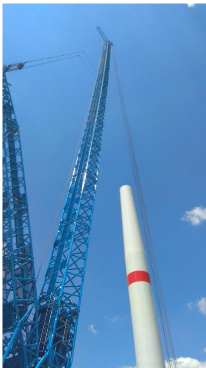
Obr. 1 (zľava): Pohľad na výstavbu veže veternej elektrárne, rameno a základňu žeriavu
