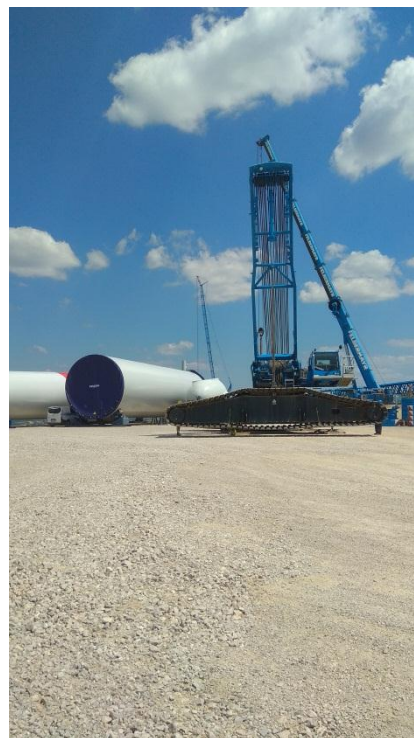
Obr. 1 (zľava): Pohľad na výstavbu veže veternej elektrárne, rameno a základňu žeriavu
