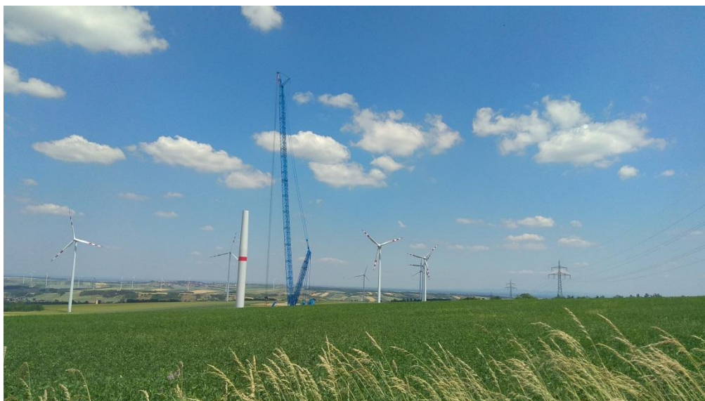
Obr. 6 : Pohľad na výstavbu veternej elektrárne južne od Altlichtenwarth
