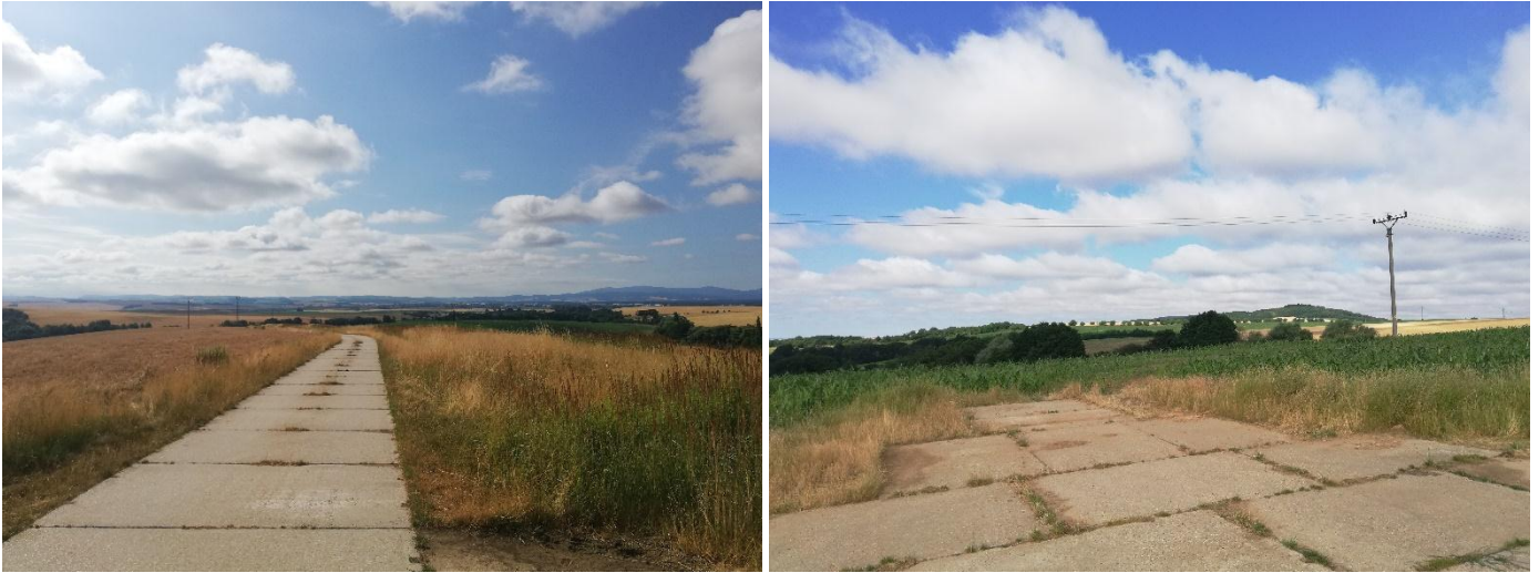
Obr. 7 a 8: Pohľad na cestnú komunikáciu smerom do obce Rohov, južným smerom z dotknutého územia (vľavo) a pohľad severozápadným smerom (vpravo)
